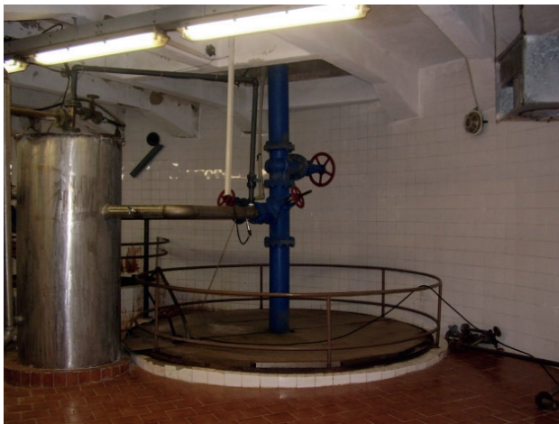
Fig. 5.15 Kúpeľný prameň spring – production installation.
