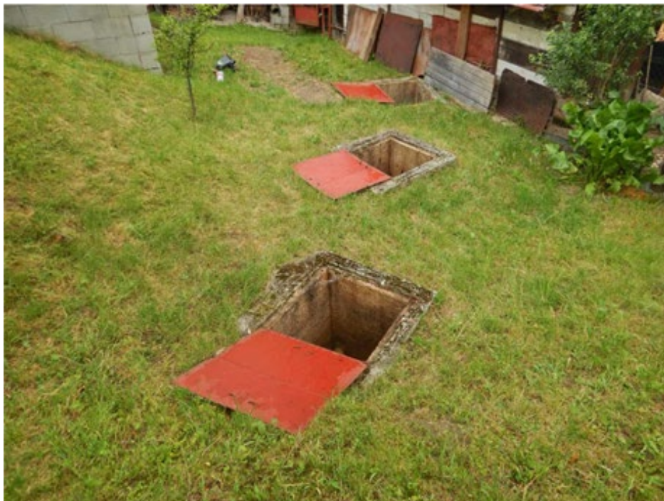
Zberné šachty s vyústením odvodňovacích vrtov na lokalite Ľubietová.
