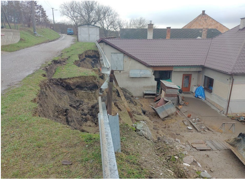
Zosuv na svahu v obci Dolné Semerovce, foto 4.1.2024, po odstránení časti akumulácie zosunutého svahu.
