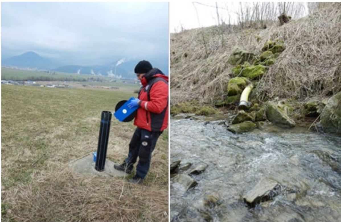
Revízia inklinometrického vrtu na lokalite Liptovská Štiavnica a revízia stavu drenážno-stabilizačného rebra na lokalite Babín – vyústenie odvodnenia.
