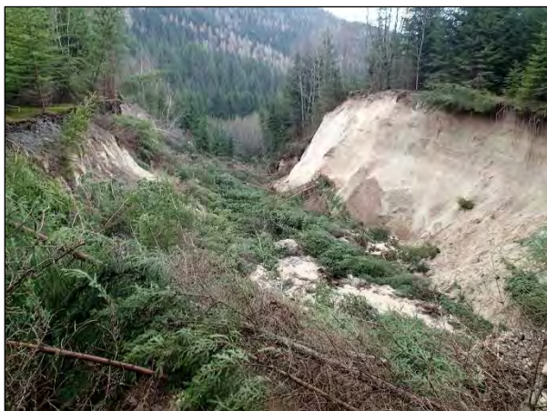
Vznik svahovej deformácie na odkalisku Lazisko – Dúbrava č. 2, bočná severovýchodná stena odľučnej časti svahovej deformácie
