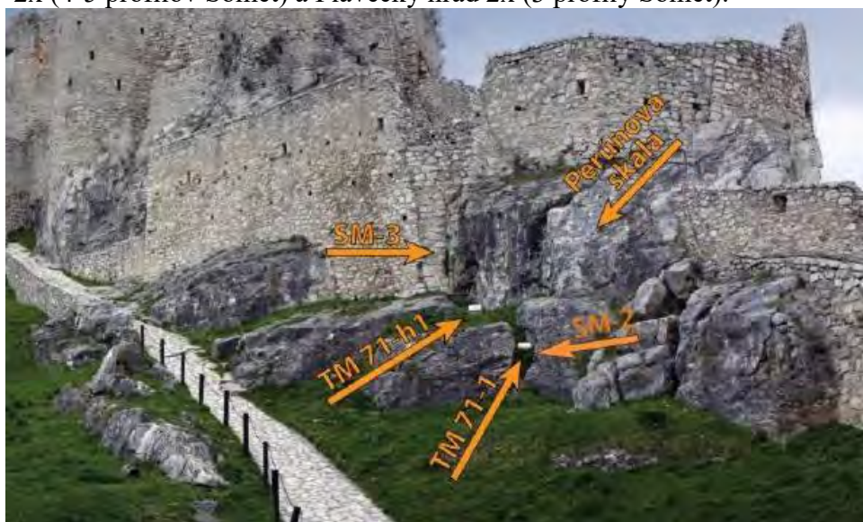
Pozícia dilatometrov TM-71-h1, TM-71-1 a stanovišť dilatometrov
