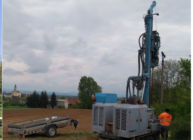
Vrtanie vrtu PN-2 (Svodín) vrtnou súpravou Prakla RB-8
