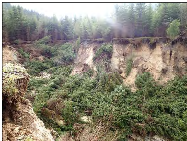
Bočná juhozápadná stena odľučnej časti svahovej deformácie
