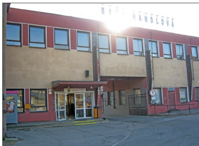
Obr. 5. Stanovisko 13 – hlavný vchod do závodu bane Handlová.
